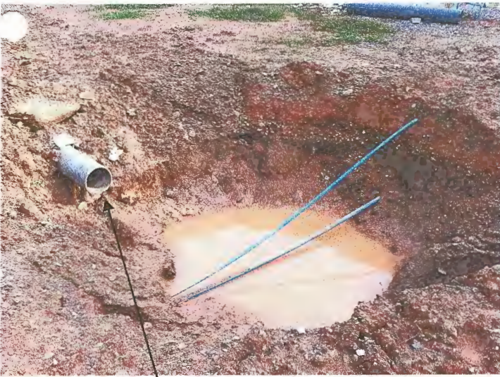
ท่อระบายน้ำแบบโยหิน เส้นผ่าศูนย์กลาง 8 นิ้ว
