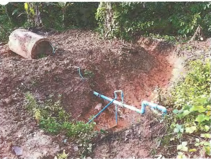
ท่อระบายน้ำแบบโยหิน เส้นผ่าศูนย์กลาง 8 นิ้ว
